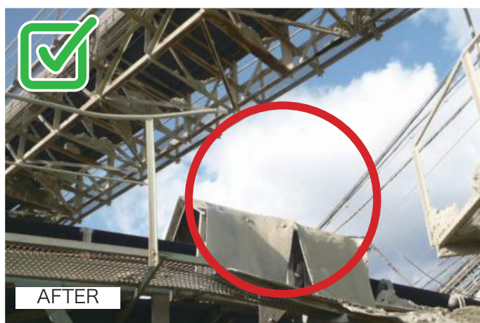
NVC ベルトクリーナ取付後
